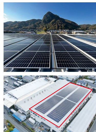
※赤線部太陽光パネル設置部
